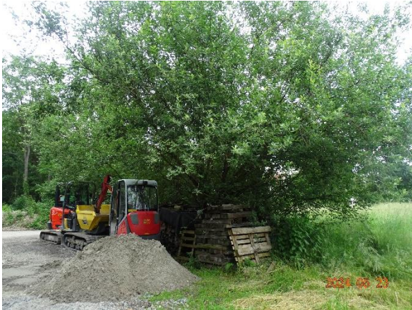
Abb. 4: Lagerfläche im Norden des Plangebietes
